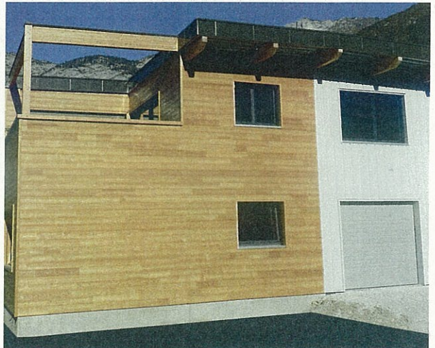
Revestimiento de Alerce finger-joint, veta resaltada y acabado Pigmenté +, 5 años de garantía, que protege del gris a lo largo tiempo.
